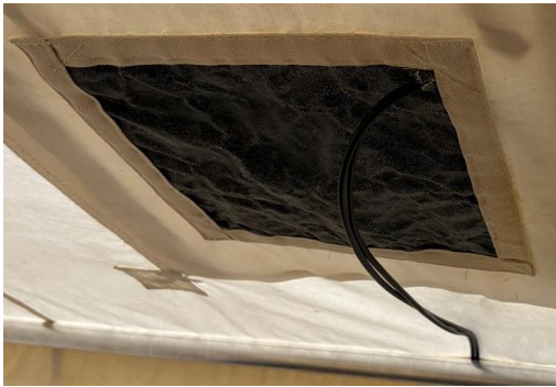
Abbildung 3: Dachdurchführung für die Kabel
